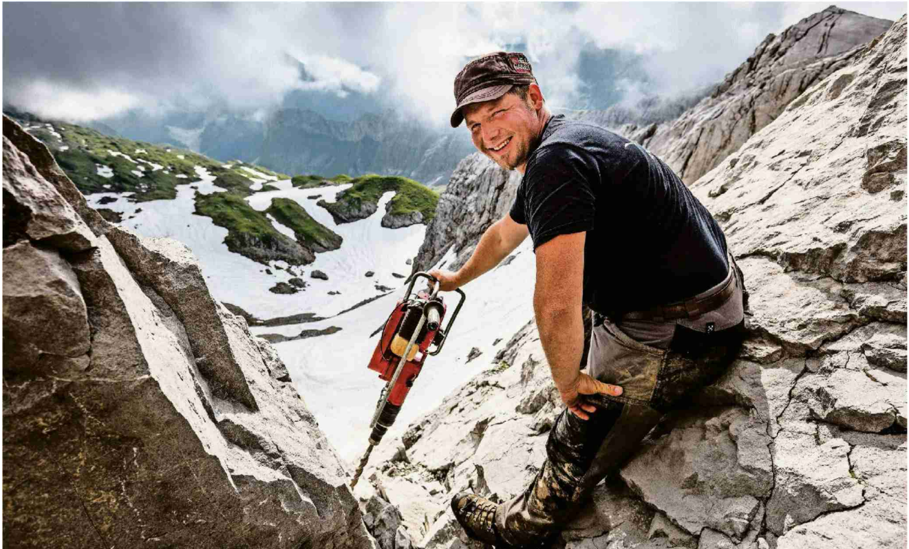
Dicker Brocken: Patric Hautle bohrt ein Loch für eine Sprengladung in den Felsen
